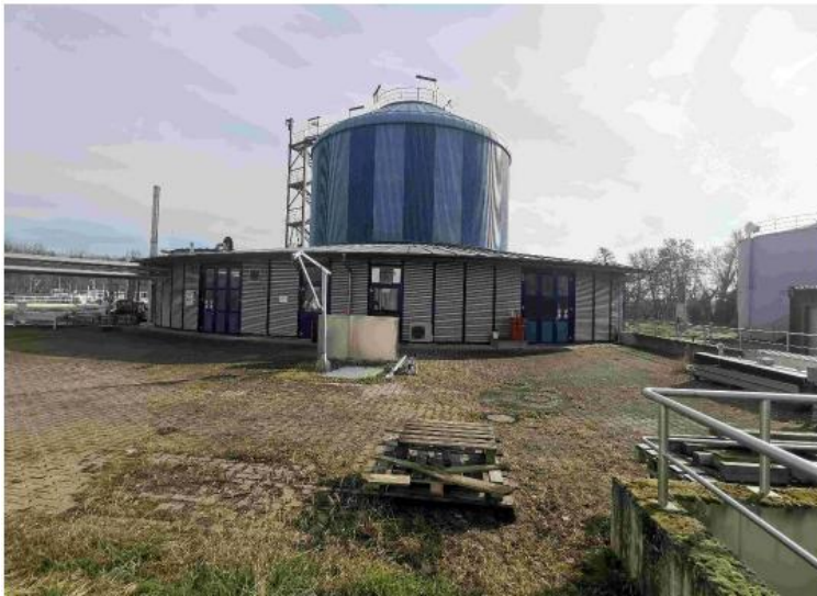
Abb. 2: Zufahrt zum Betriebsgebäude. Tor zur Eindickung auf der rechten Seite
